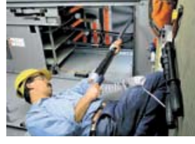
Montáž staniční koncovky
