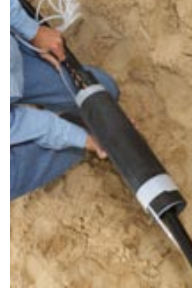
Smřštění vnější ochranné trubice
